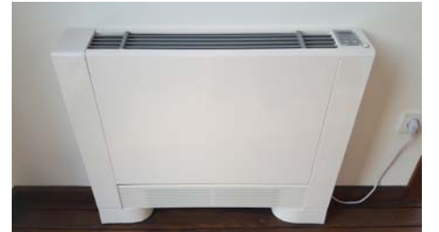
THE LIFECO-MANDARİN BAĞÇESİ-TÜRKBÜKÜ NEWTHERM DÖŞEME TİPİ FANCOİL
